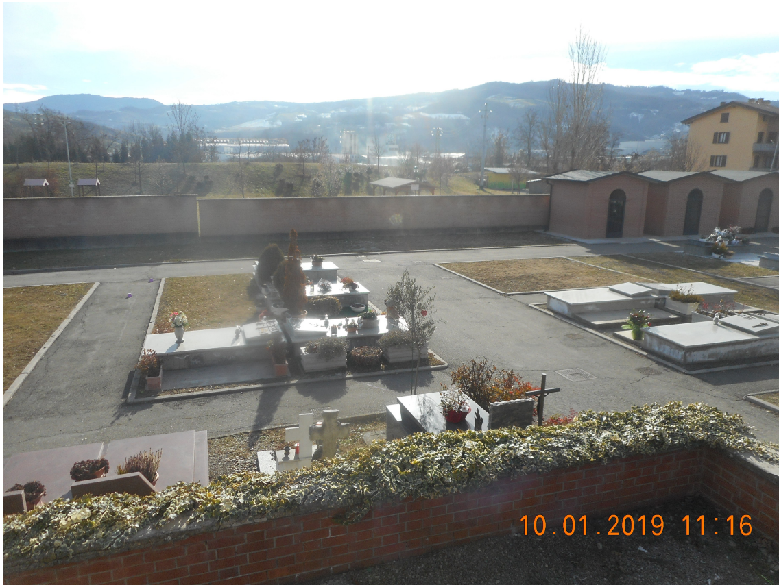
Foto 5: vista area di realizzazione loculi da W
