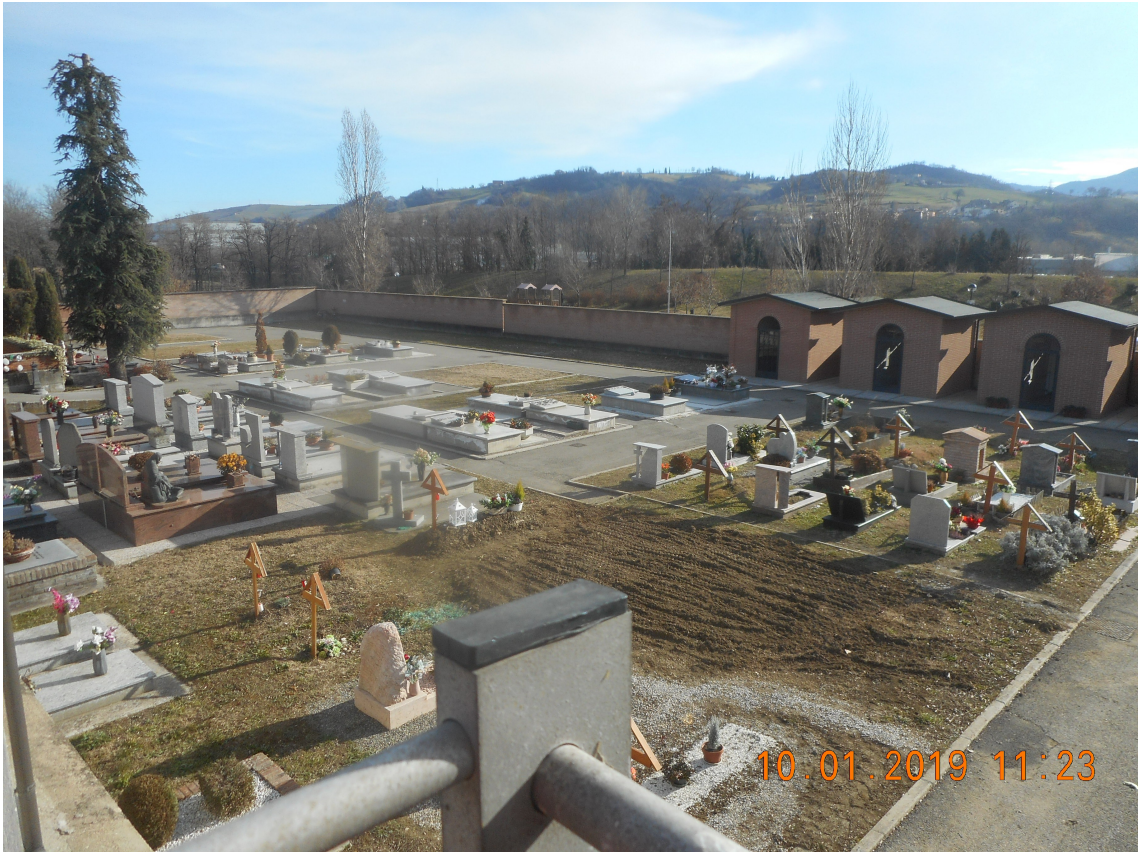
Foto 1: vista area di realizzazione loculi da SW
