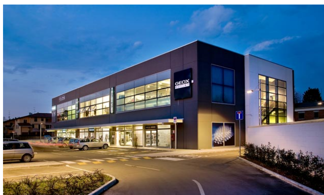
Edificio commerciale a Boretto, Reggio Emilia (Italy)
